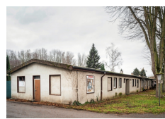
Erhalten sind noch etliche Baracken der ehemaligen Zwangsarbeiter-siedlung der Zeche Constantin.
